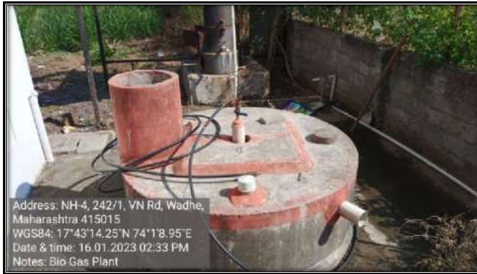
Fig. 7.1.2.7. Biogas plant
